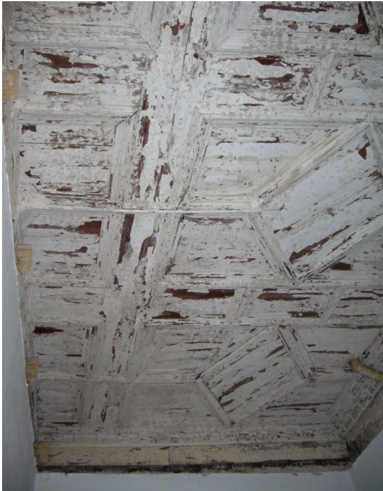
Kassettendecke nach entfernen der Unterkonstruktion von 1952 und nach Abbürsten August 2008
