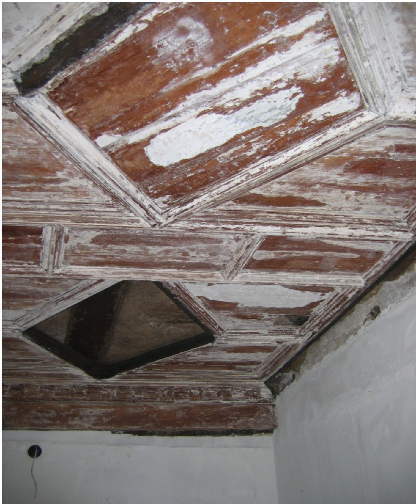
Kassettendecke nach mechanischem Entfernen der losen Kalkfarbschichten im November 2009
