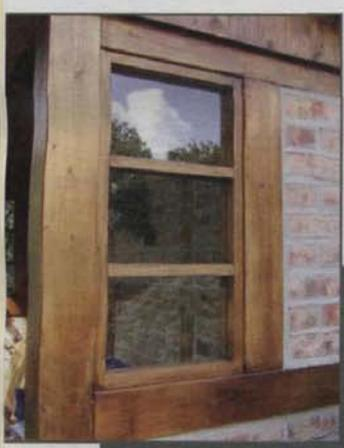
Die Fensterkonstruktion besteht aus zwei identischen Rahmen. Erst den äußeren Rahmen einschrauben, dann die Glasscheibe einsetzen und anschließend den zweiten Rahmen montieren.
